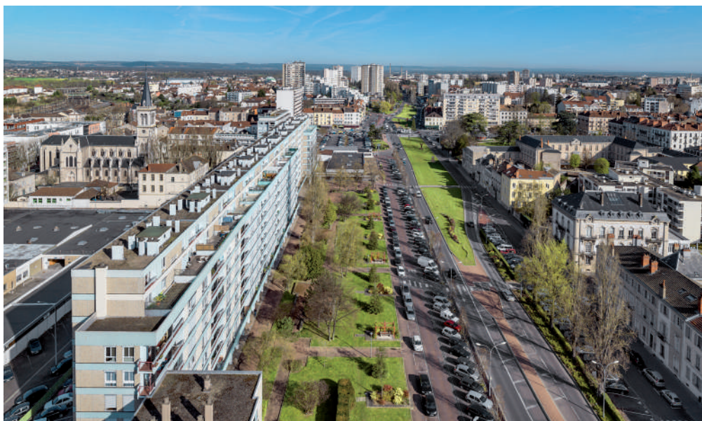
Barre du canal, avenue Nicéphore Niepce, Chalon-sur-Saône sous la direction de Daniel Petit architecte. Cliché : Thierry Kuntz, 2015.
