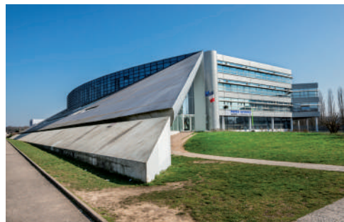
Façade d'entrée et angle nord-ouest du bâtiment socio-éducatif, lycée Gustave Courbet, Belfort. Jean-Pierre Drezet. Cliché : Yves Sancey, 2009.
