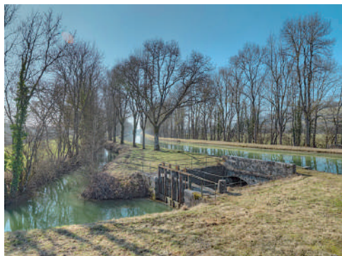
Le contre-fossé rejoignant la Brionne avant son passage sous le canal de Bourgogne au moyen de l'aqueduc visible au premier plan. Bief 12 du versant Yonne à Eguilly. Daniel Petit. Cliché : Thierry Kuntz, 2012.
